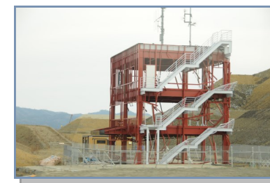
【震災遺構 南三陸町防災庁舎】
